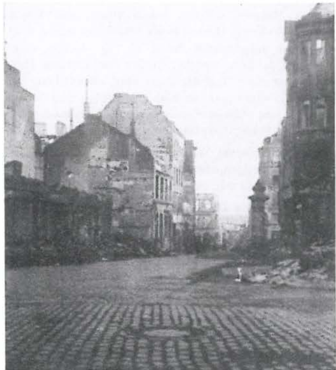
Haus Tonger (rechts), Am Hof. Nach der Kriegszerstörung.
