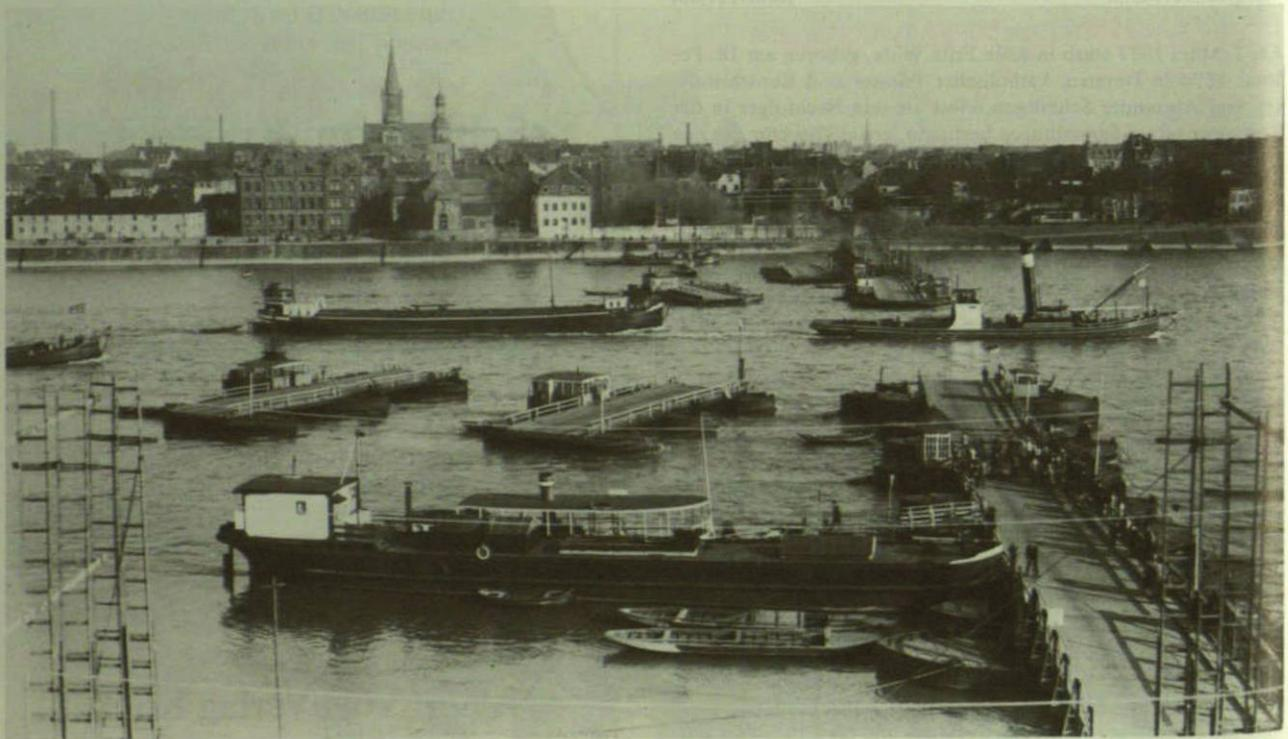
Die Mülheimer Schiffsbrücke mit ausgefahrenem Mittelteil um 1927
